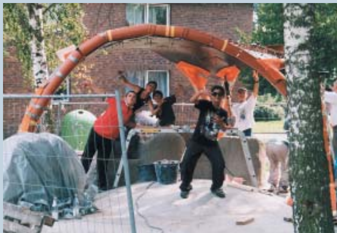
Sonnensegel und Sitzgruppe im Rohbau
