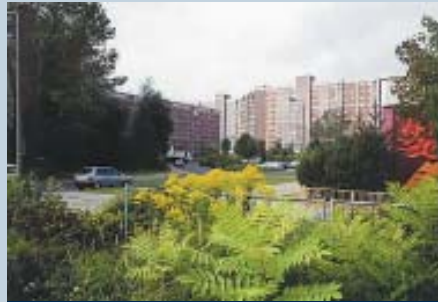
Standort Groß Klein: Gerüstbauerring, Rostock
